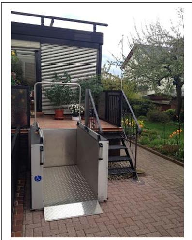
Der Bügel für die obere Haltestelle ist an Ihrer Hebebühne installiert und bietet einen einfachen Schutz gegen Absturz. Installiert wird der Bügel an der Bühne und fährt mit dieser mit.
